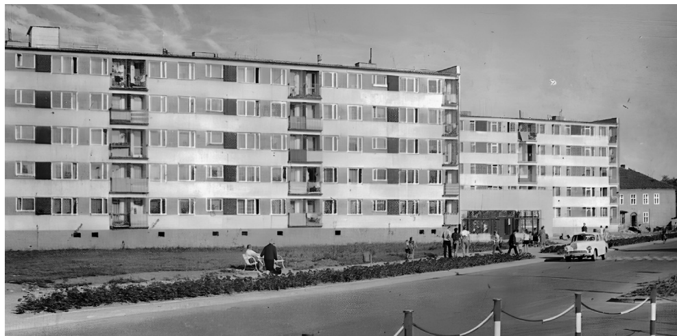
Ryc. 9. Zabudowa osiedla Śródmieście od strony nowo wytyczonej ulicy Sikorskiego. Lata siedemdziesiąte XX w. Źródło: fotografia z Archiwum Klubu Nowodworskiego.
