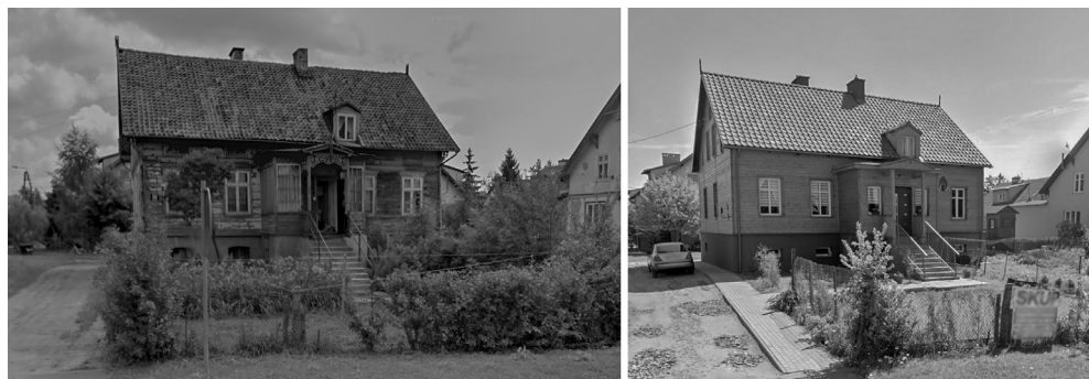
Ryc. 10. Budynek mieszkalny z końca XIX w., ujęty w gminnej ewidencji zabytków i położony w strefie ochrony konserwatorskiej. Przeprowadzona między 2019 a 2023 rokiem termomodernizacja doprowadziła do destrukcji oryginalnej struktury. Źródło: Google Maps Street View.
