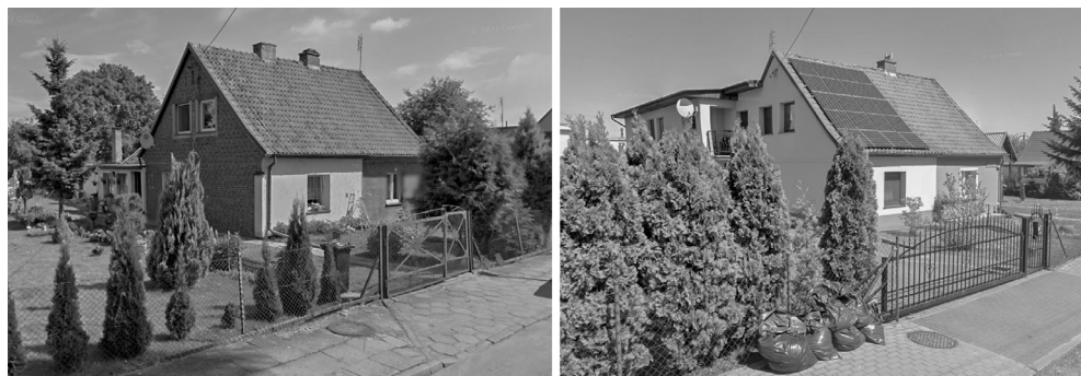
Ryc. 12. Budynek mieszkalny z pierwszej połowy XX w., nie ujęty w gminnej ewidencji zabytków. Przeprowadzona między 2013 a 2023 rokiem termomodernizacja oraz rozbudowa doprowadziły do destrukcji oryginalnej struktury. Źródło: Google Maps Street View.
