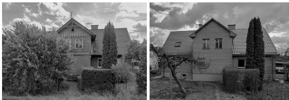
Ryc. 11. Budynek mieszkalny podcieniowy z początku XX w., nie ujęty w gminnej ewidencji zabytków. Przeprowadzona między 2019 a 2021 rokiem termomodernizacja doprowadziła do destrukcji oryginalnej struktury. Źródło: Google Maps Street View.
