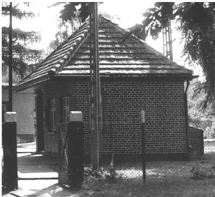
Ryc. 8. Budynek recepcji w 1986 r. z oryginalnymi oknami otwieranymi na zewnątrz. Źródło: Zbiory DPS „Słoneczne Wzgórze”
