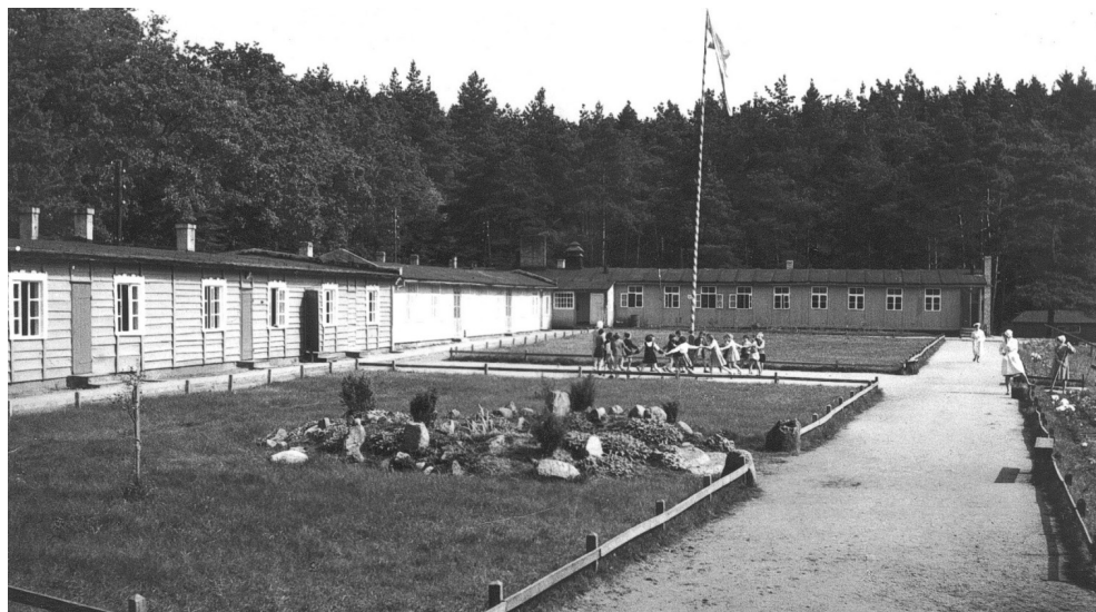
Ryc. 11. Baraki Służby Pracy Rzeszy po adaptacji na prewentorium dla dzieci, przed 1966 r. Źródło: Zbiory DPS „Słoneczne Wzgórze”
