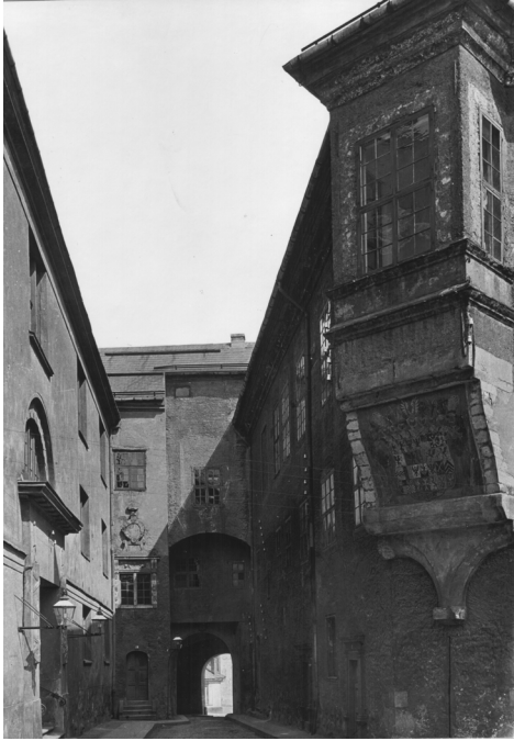
Abb. 9. Die Hofseite des Albrechtstores mit dem kleinen Zwischenbau zum östlichen Nordflügel (links), Fensterumrahmung im ersten Obergeschoss; ursprünglich besaßen auch die Türe und die anderen Fenster reichere Einfassungen (Abb. 6); Sammlung Museum Stadt Königsberg, Lüneburg.
