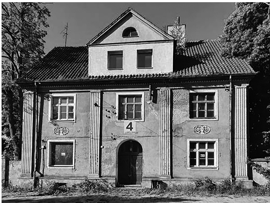
Ryc. 3. Budynek dawnego Urzędu Miar w Olsztynie, ul. Lubelska 4, stan na rok 2022. Fot. Robert Roguszka
